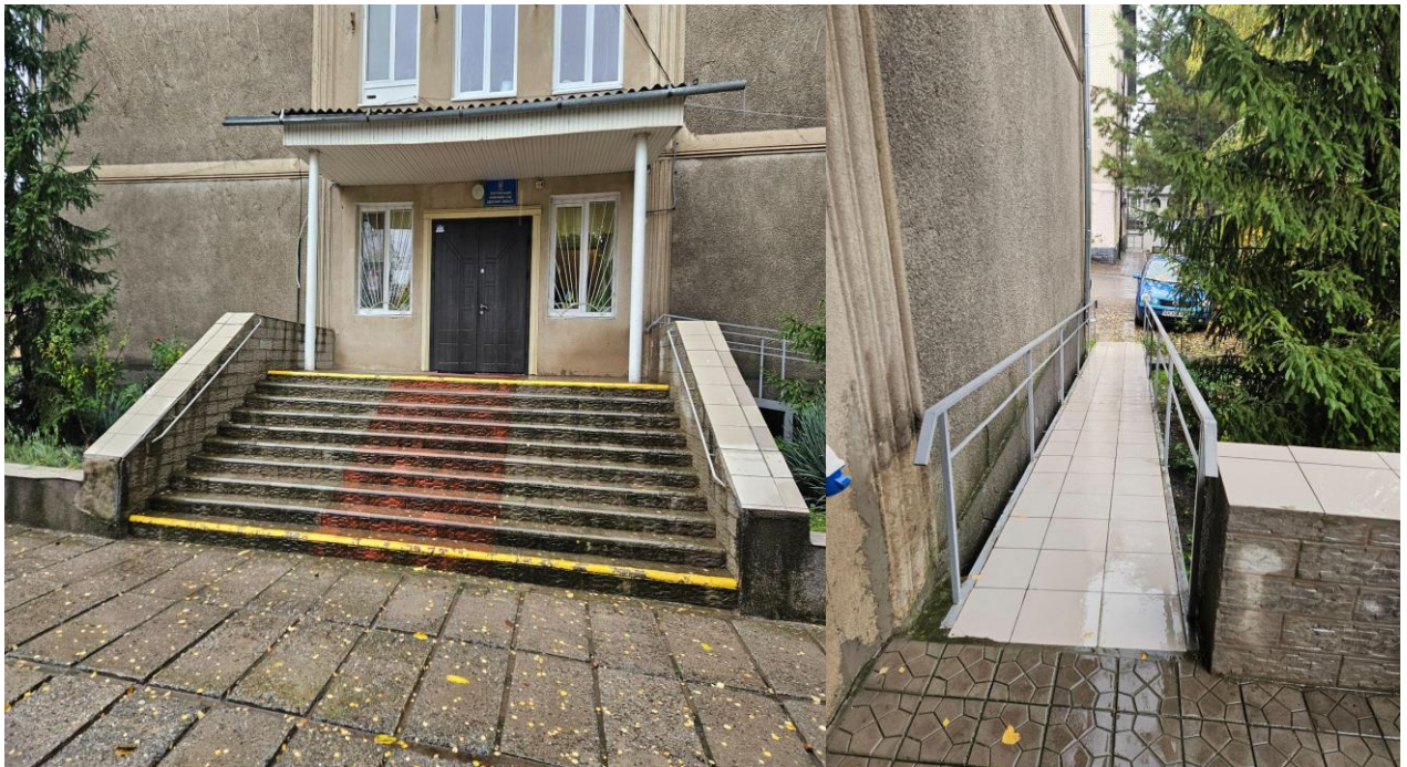
Фото 1 - Будівля Тарутинського районного суду
