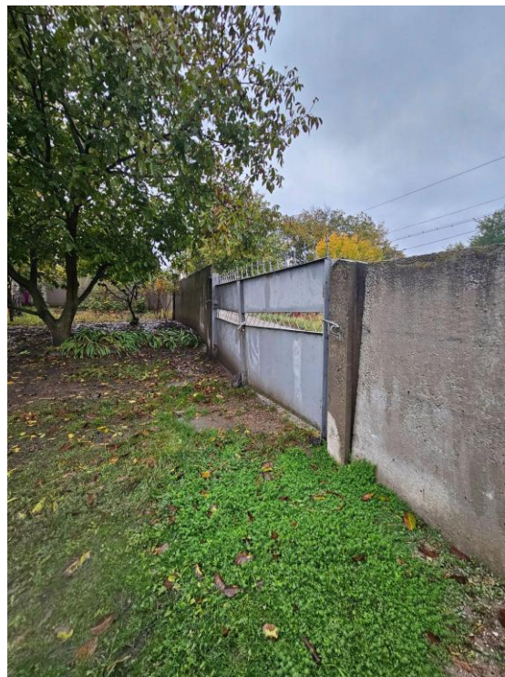
Фото 2 - В'їзд на задньому подвір'ї
